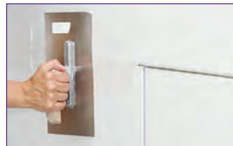
7. Stoßfugen bis zur ausreichenden Glätte mit Metylan RenoMur Spachtelmassen überarbeiten.
