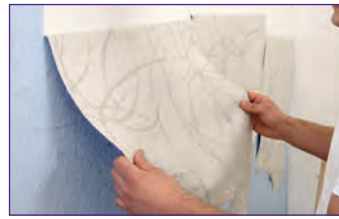
1. Alte Tapeten und Beschichtungen entfernen. Risse und Löcher schließen und die Fläche glätten.
