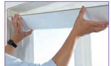
6. Fensterlaibungen mit speziellen Laibungsplatten dämmen.
