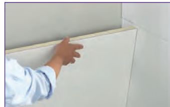
5. Platten fugenlos auf Stoß verkleben.
