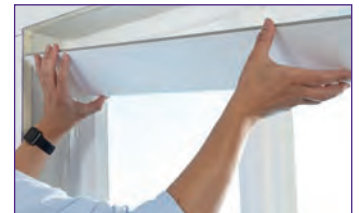
6. Fensterlaibungen mit speziellen Laibungsplatten dämmen.
